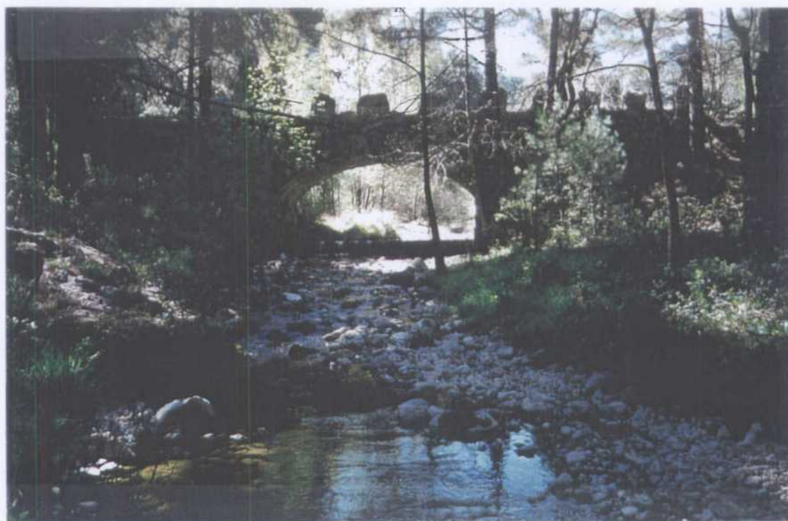
Puente sobre el río Guadalquivir
