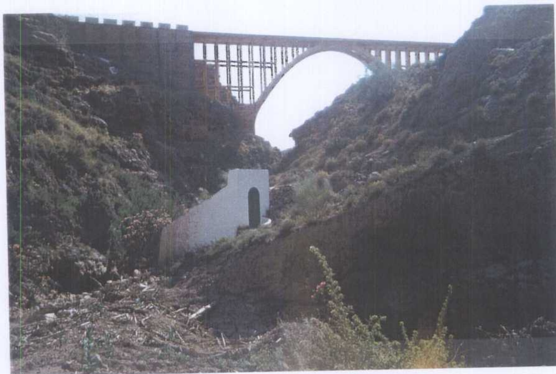
Captación para abastecimiento a Hinojares
